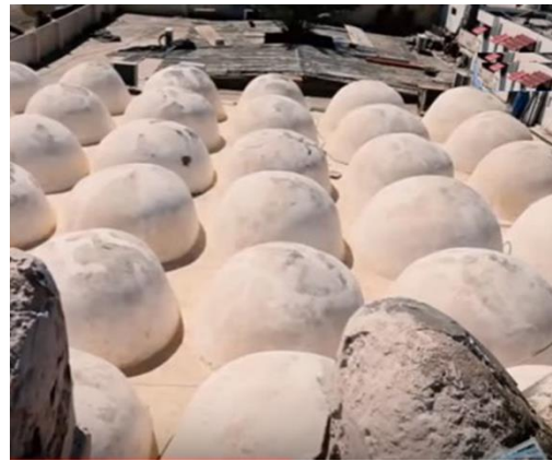
Fig. 32. Vue sur la toiture de la mosquée al-Nâka à Tripoli.
