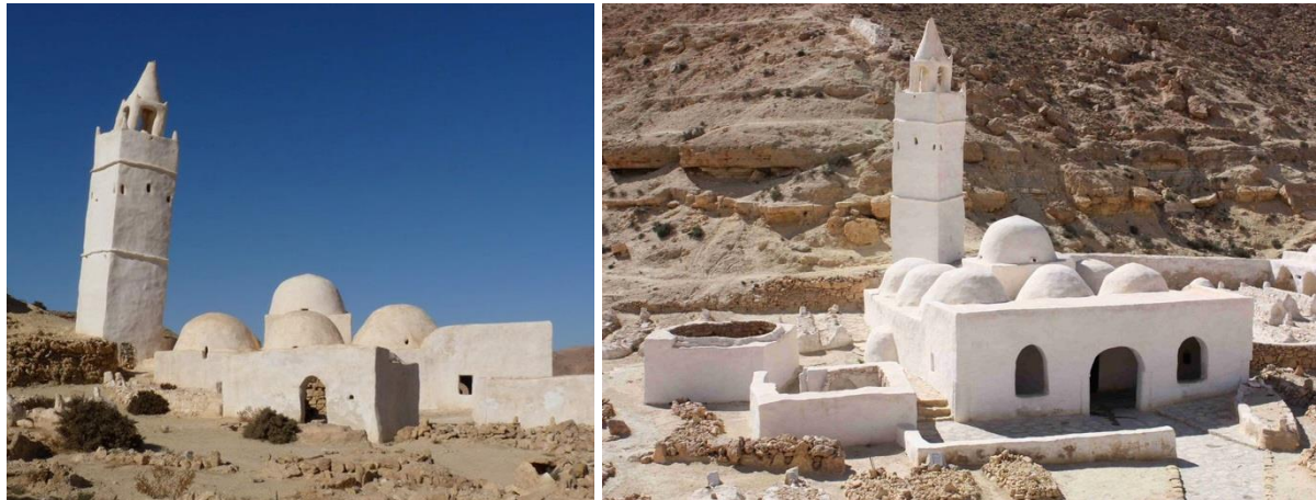
Fig. 4 et 5. Vues extérieures sur la mosquée.
