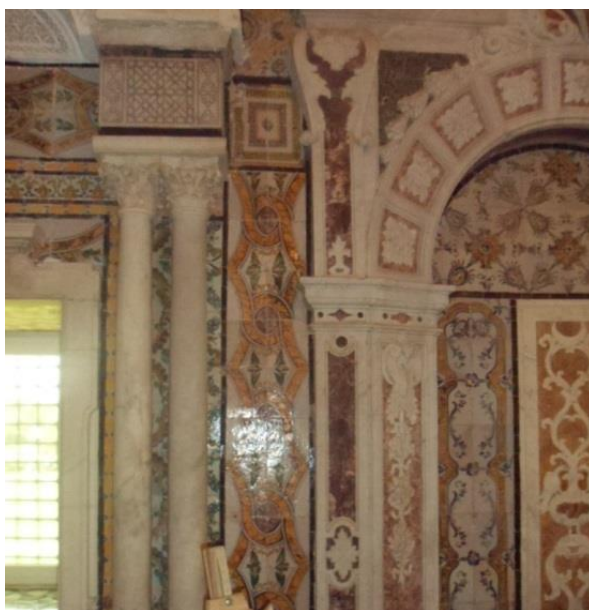
Fig. 5. Un panachage de parement polychrome entre céramique et marqueterie de marbre.
