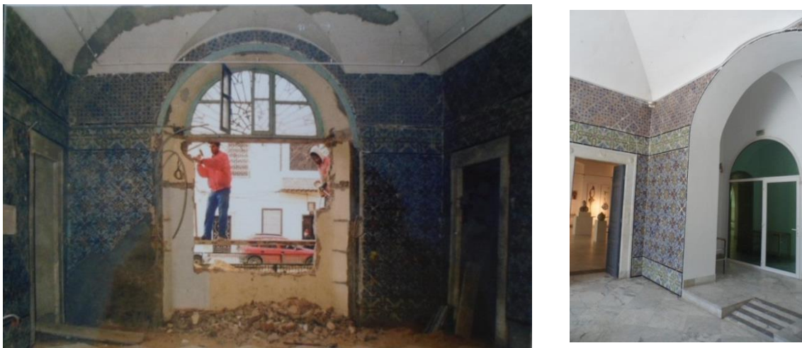
Fig. 6. La première salle du palais Kheireddine qui a gardé son revêtement en carreaux polychromes. Une ancienne porte murée a été ré-ouverte à l'occasion des travaux de restauration. La deuxième photo prise en 2018 représente le palais converti en musée de la ville.
