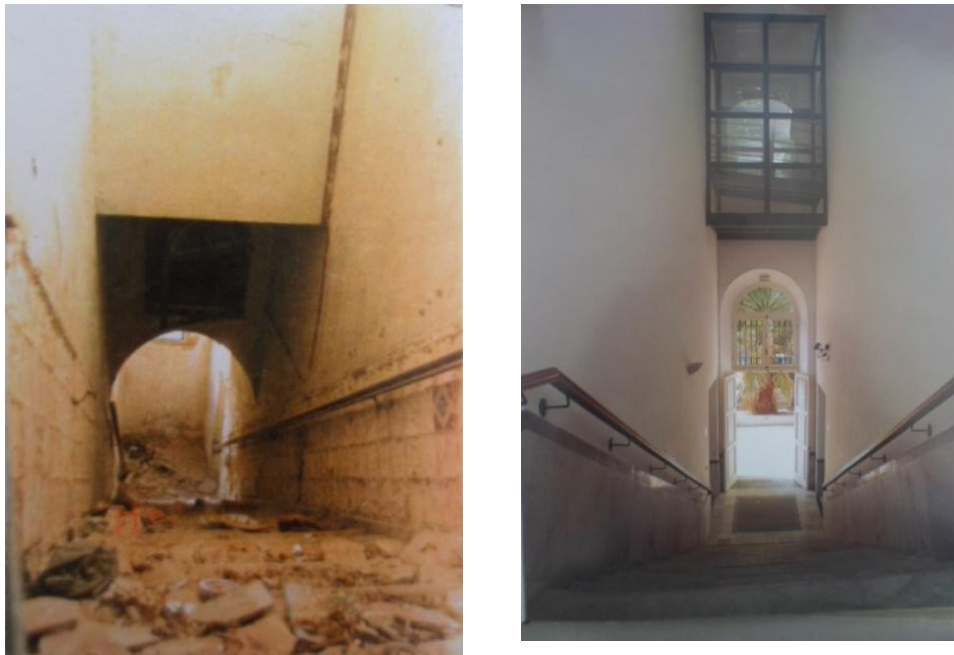
Fig. 7. La cage d'escalier avant et après les travaux de restauration entamés en 1994. Les carreaux de céramique sont remplacés par un lambrisage de marbre blanc d'Italie.
