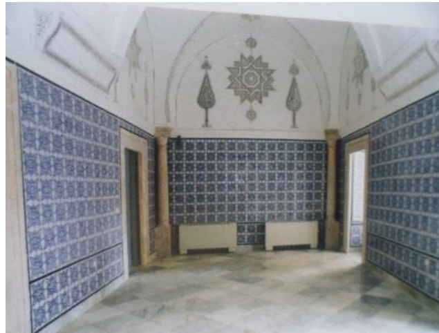
Fig. 4. La driba après les travaux de restauration. On remarque les carreaux d'imitation qui prennent place sur les parois. Un essai de restitution de l'aspect initial du palais.
