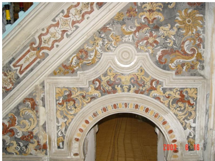
Fig. 8. Le minbar de la mosquée de Husayn b. ʿAlî : détail du parement polychrome de marqueterie de marbre du minbar .
