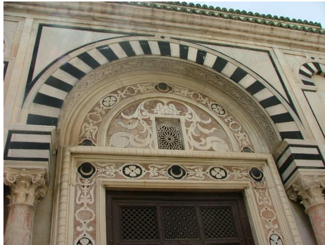
Fig. 5. Marqueterie de marbre tapissant le tympan au-dessus de la porte du mausolée de Hammûda Pacha.
