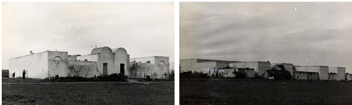
Fig. 26. « Immeuble de recasement 1 » et « immeuble de recasement 2 » du recasement « Route de Mateur » à Ferryville, source, source, Archives Nationales de Tunisie, boîte 34, versement 74, année 2008.
