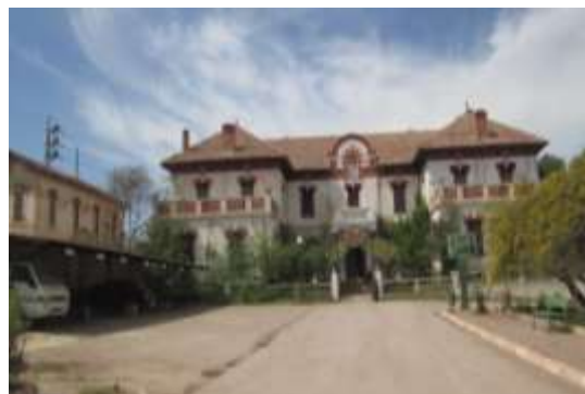
Bâtiment de la Direction de la Mine de Djebel Djerissa (Octobre 2014)
