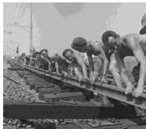
Fig. 4. Mise en place des rails de chemin de fer par des ouvriers locaux
