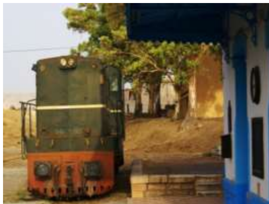
Fig.10. La gare de Djerissa avec ancienne locomotive
