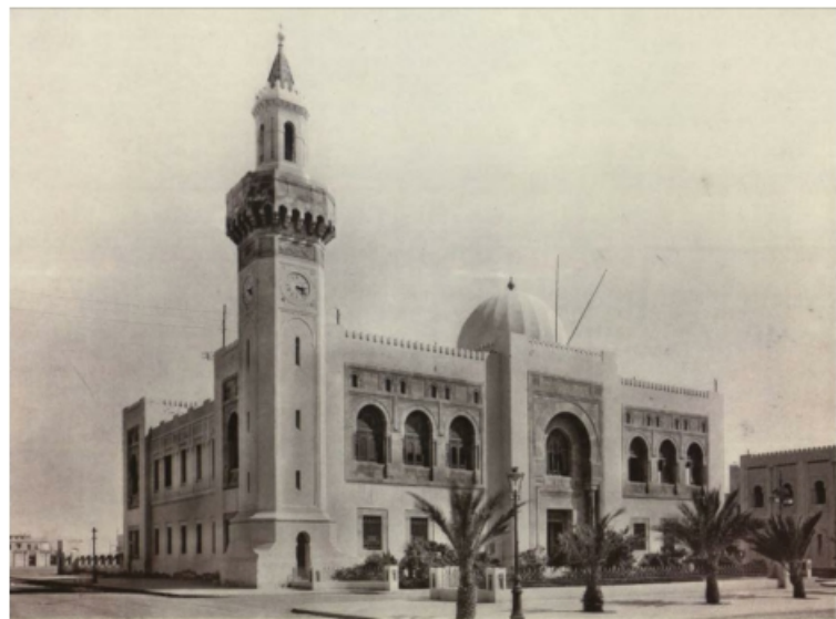
Fig. 6. Façade principale, Hôtel de Ville de Sfax. Vers 1906.
