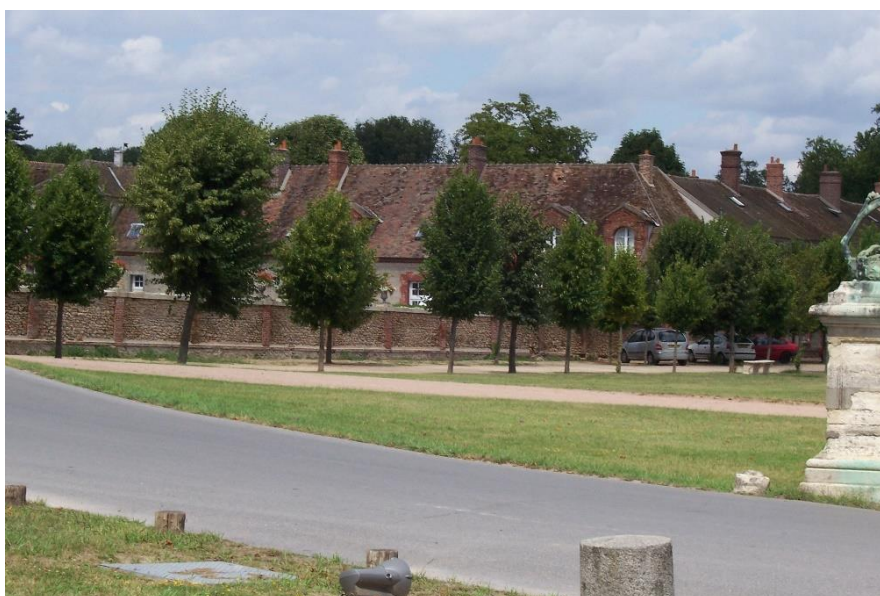
Fig. 2. Vue actuelle des fermes du château de Grosbois (Photo prise en 2006).
