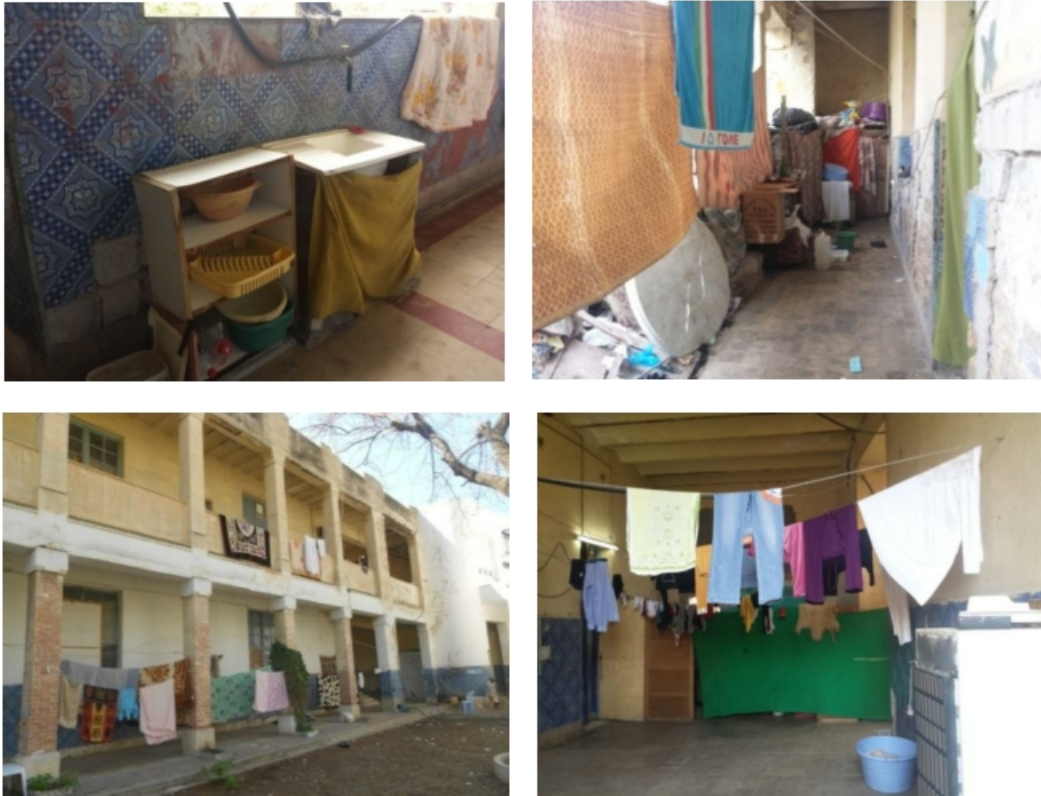
Fig. 3. Le détournement fonctionnel de la galerie.
