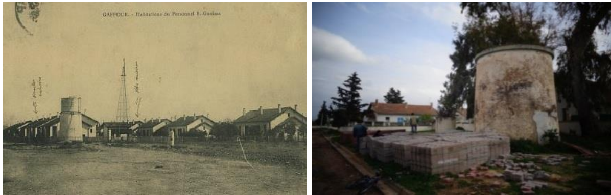
Fig.26-27. Les équipements d'adduction d'eau
