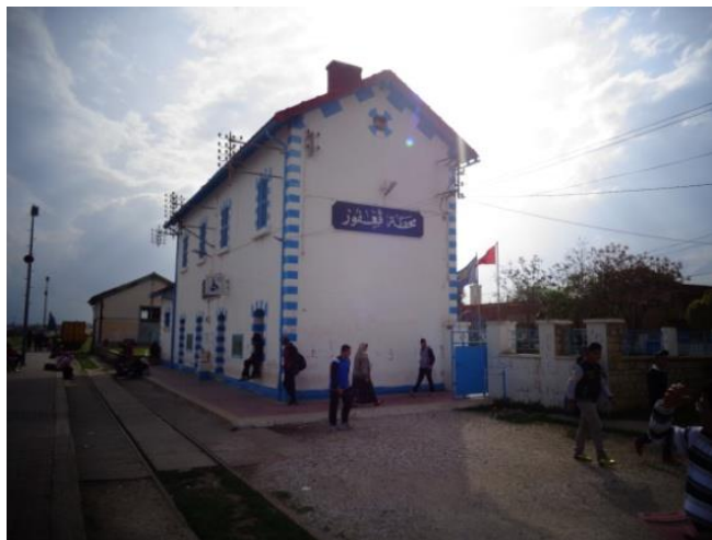
Fig.1. La gare de Gaâfour
