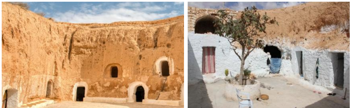
Fig.4. Matériau et technique de construction. Source : Yasmine Chaniour, 2018.
