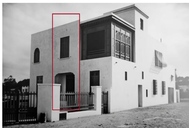
Fig. 18. Position du patio depuis l'extérieur de la villa Fellus. Source : Victor Valensi (2008), planche 22.
