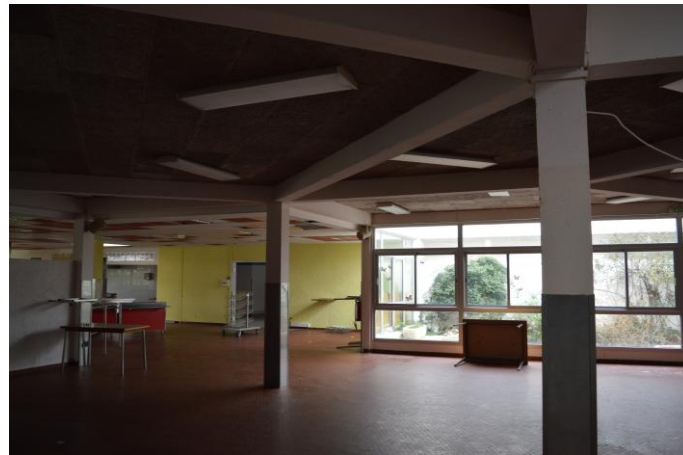
Fig. 6. L'équipement de front de mer du village de vacances "Les Carrats". Source : Corentin Claret
