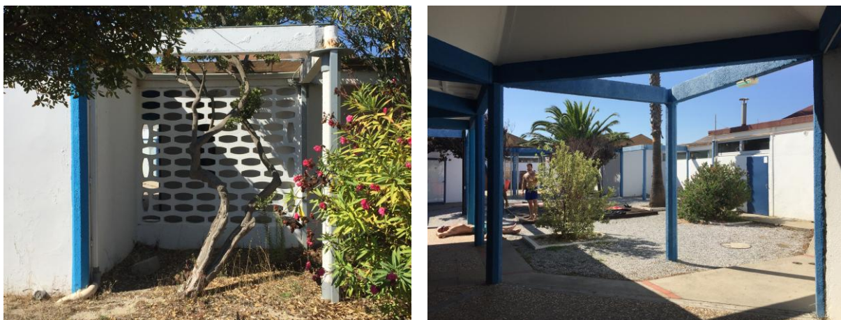
Fig. 8. Centre Méditerranéen de Nautisme depuis l'extérieur (à gauche) et l'intérieur (à droite). Source : Corentin Claret
