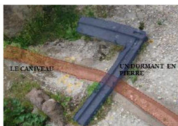
Fig.17. Photo du seuil du corridor d'accès, montrant le caniveau et le dormant en pierre de la porte l'auteur. Source : l'auteur.
