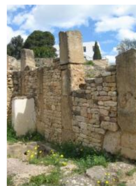
Fig.16. Photo sur l'opus africanum. Source : l'auteur.
