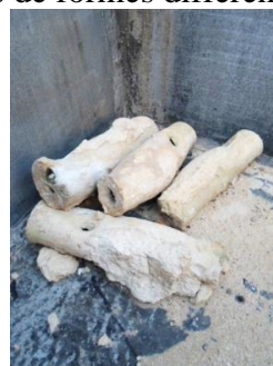
Fig. 25 : Les poteries de l'extrados du dôme. Photo de l'auteur le 18-01-2018.
