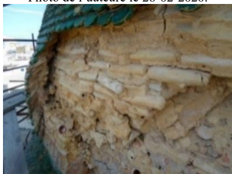
Fig. 26 : Les couches de l'extrados du dôme. Photo de l'auteur le 20-01-2018.
