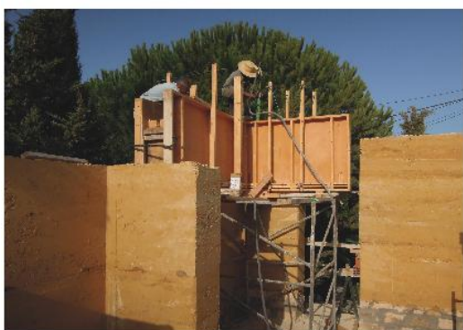
Fig. 4. Mise en œuvre de la terre
