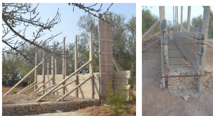
Fig. 15. Coffrage fabriqué pour la construction du mur en pisé.
