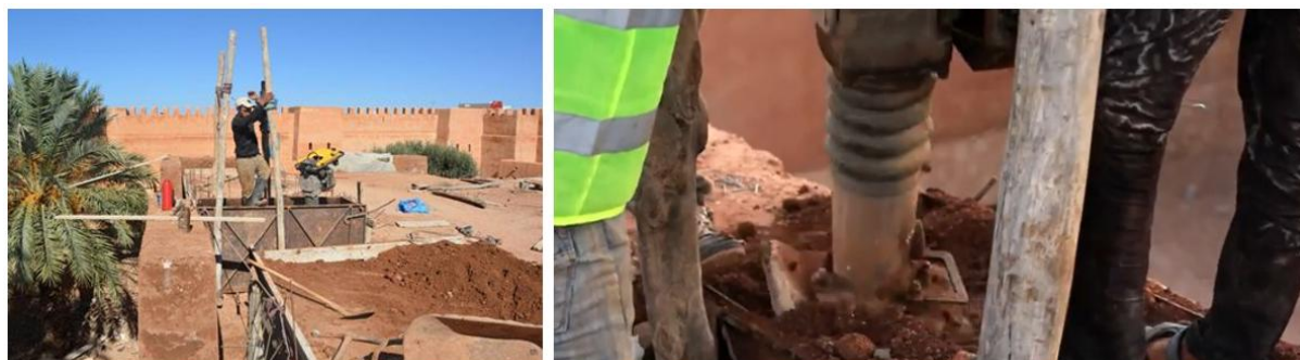
Fig. 2. Coffrage métallique du mur (à gauche),
