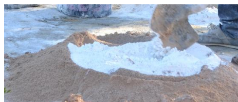
Enduit de terre (terre de pisé + chaux)
