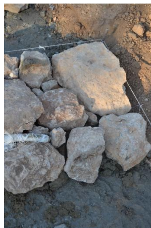
Fig. 12. Construction du soubassement en pierres
