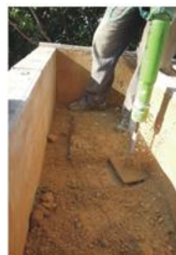
Fig. 5. Damage pneumatique
