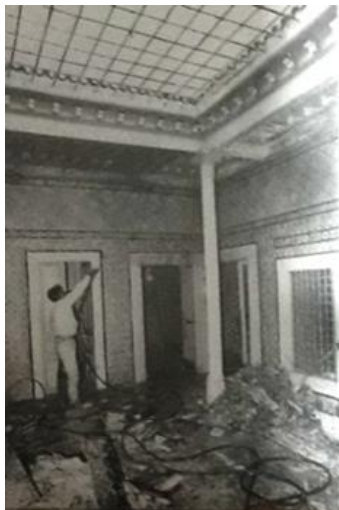
Fig. 5. Restauration du pavage en marbre de Carrare 19 .
