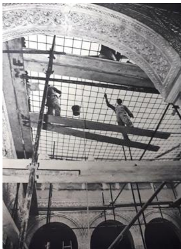
Fig. 3. Travaux de réaffectation 12 .
