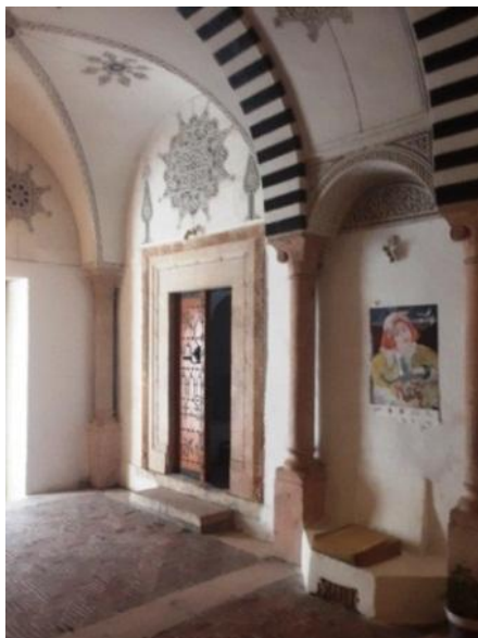
Fig. 1. Le revêtement sobre de la Driba . (Photo de l'auteur).
