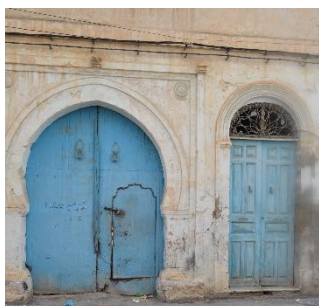
Fig. 4. Portes d'une dār et de son mahzan à M'Saken Source : Photos des auteures
