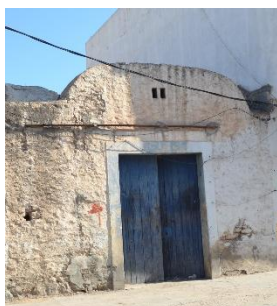
Fig. 3. Mahzan d'une maison non identifiée à Kalaa Kébira
