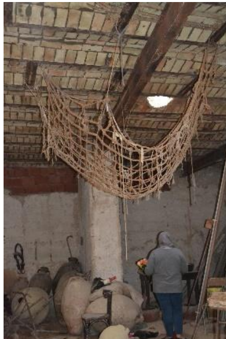
Fig. 25. Filet pour déshydrater les légumes accrochés à la toiture du maḥzan de dār Ben Rjab (al-Knaies) Source : Photo des auteures
