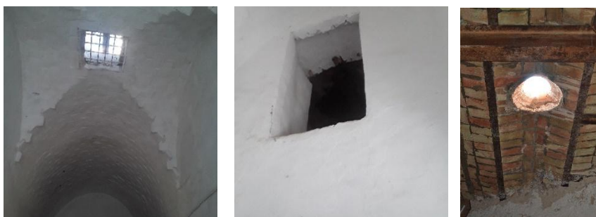
Fig. 7. Cas très rares de baies d'aération à bît al-ḥzîn repérés respectivement à dār Hafsa (M'Saken) et dār Ben Rjab (al-Knaies)
