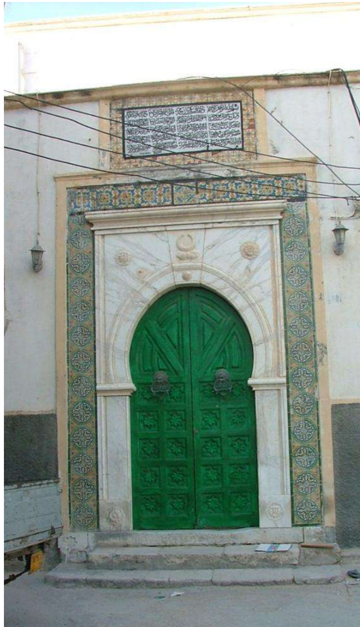
Fig. 13. Mosquée Gurgi. Porte d'entrée orientale. Source : Ahmed Saadaoui 24 février 2005.
