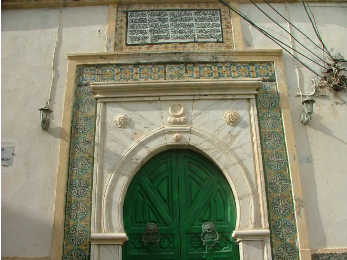
Fig. 14. Mosquée Gurgi . L'inscription de fondation placée au-dessus de la porte d'entrée orientale. Source : Ahmed Saadaoui 24 février 2005.
