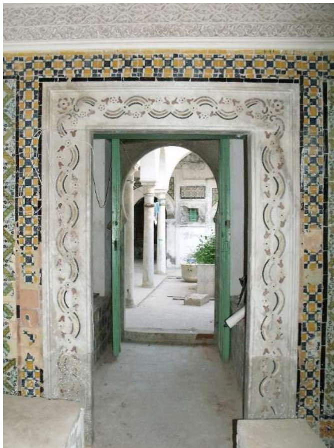
Fig. 31. La porte d'entrée de la madrasa. Source : Ali Ben Sassi 2009.
